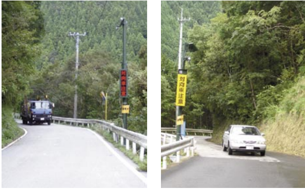
LED 文字表示方式 LED 点滅+固定文字方式 図1 中山間道路走行支援システム
