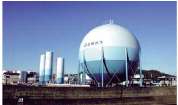
図3 四国ガスタンク高知工場
