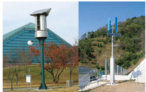
図5 サボニウスタイプ(左:大学内設置)とジャイロタイプ(右:株式会社スカイ電子提供 5) )の太陽光と風力発電ハイブリッド街路灯
