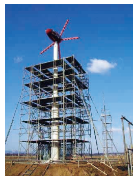
図 19 10kW 発電機(株式会社スカイ電子提供 5) ) とマグナスタイプ発電機(秋田マグナス協会 8) )
