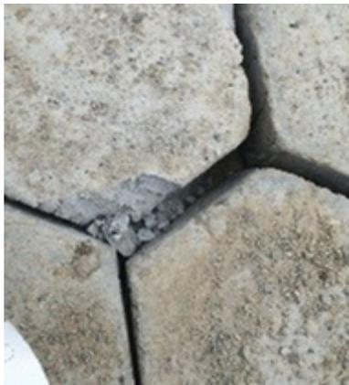
図 8. 車両荷重によるブロックの隙間からの欠け
