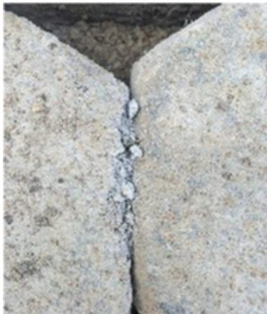
図 7. 隣接ブロック間の摩擦による破損
