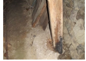
図 20. 母屋棟の柱（北側）
