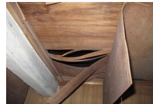
図 18. 母屋棟の天井
