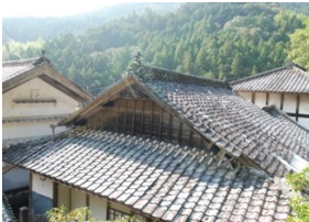
図 7. 屋根瓦の写真 (東面)
