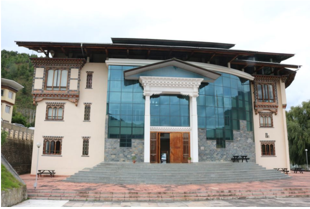
伝統建築を生かした王立ブータン大学
