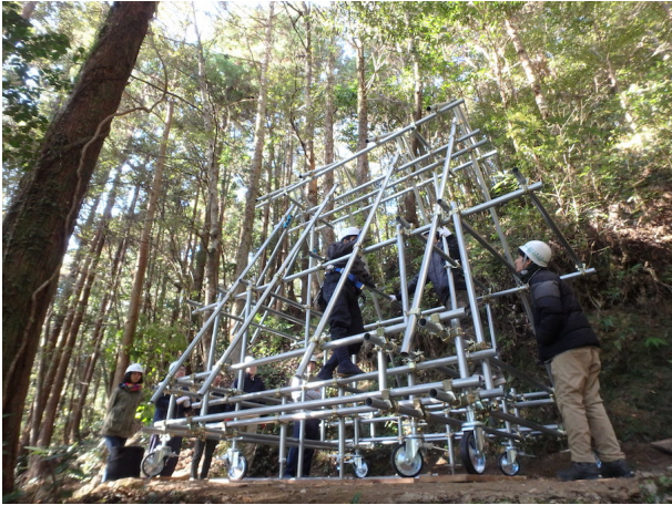
図 11. 山車社殿の施工風景
