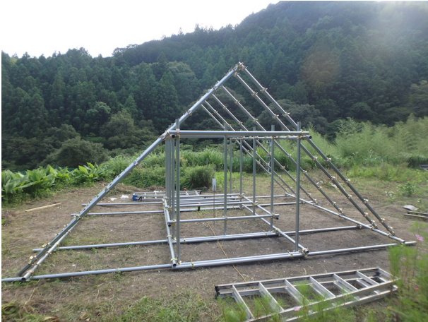
図7. 鋼管パイプによる建築構造
