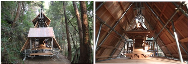
図 12. 竣工した山車社殿と移設された本殿
