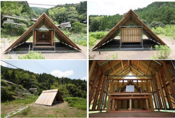
図 9. 竣工した遥拝殿
