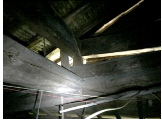
図4. 古民家の屋根裏
