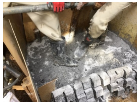
図 22. 裏込めの様子
