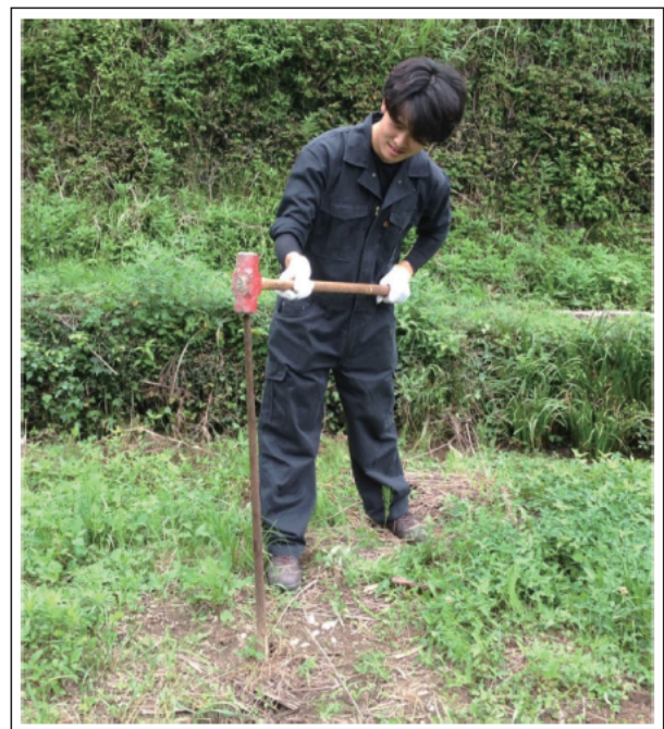
図7. 鉄棒とハンマーによる掘削
