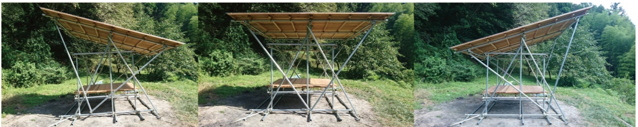
図 14. 東屋 B 屋根の調整後の写真（左：約 -16^\circ 、中央： 0^\circ （水平）、右：約 16^\circ ）
