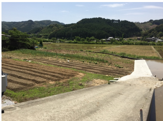
図 1-18. 既存スロープ入り口から見た敷地
