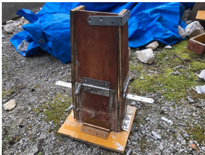
図 8-16 型枠 2 組み立てた状態
