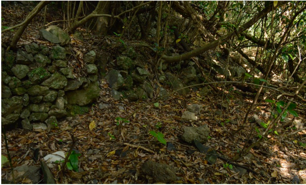
図 1-3 現況の石積みの写真 1
