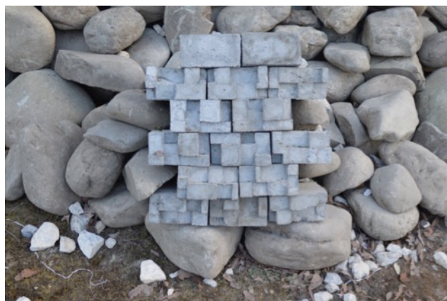
図 4-20 第3回仮施工時の完成写真
