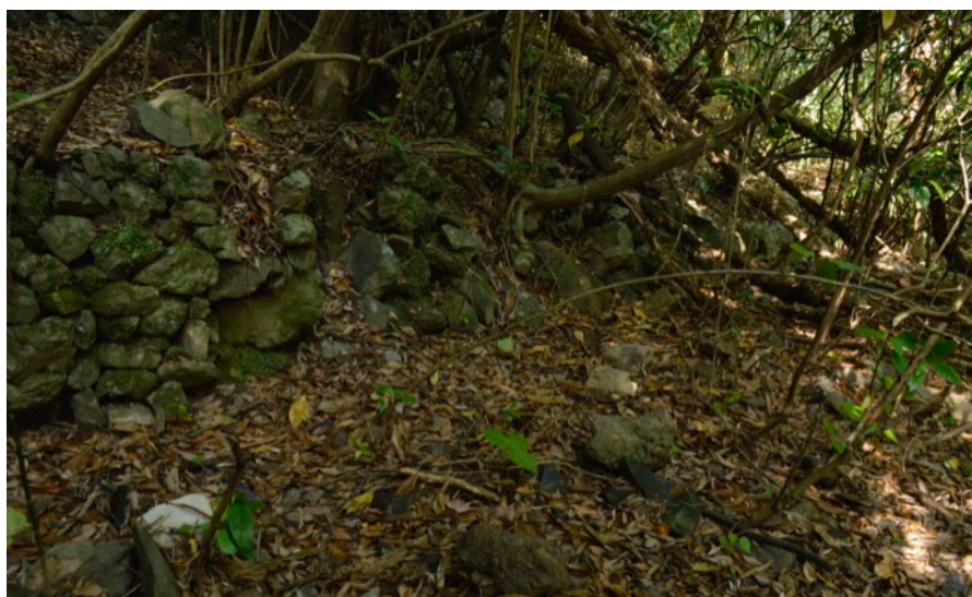
図 4-21 施工対象段差の写真
