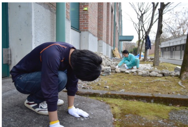
図 4-17 第2回仮施工時の施工の様子
