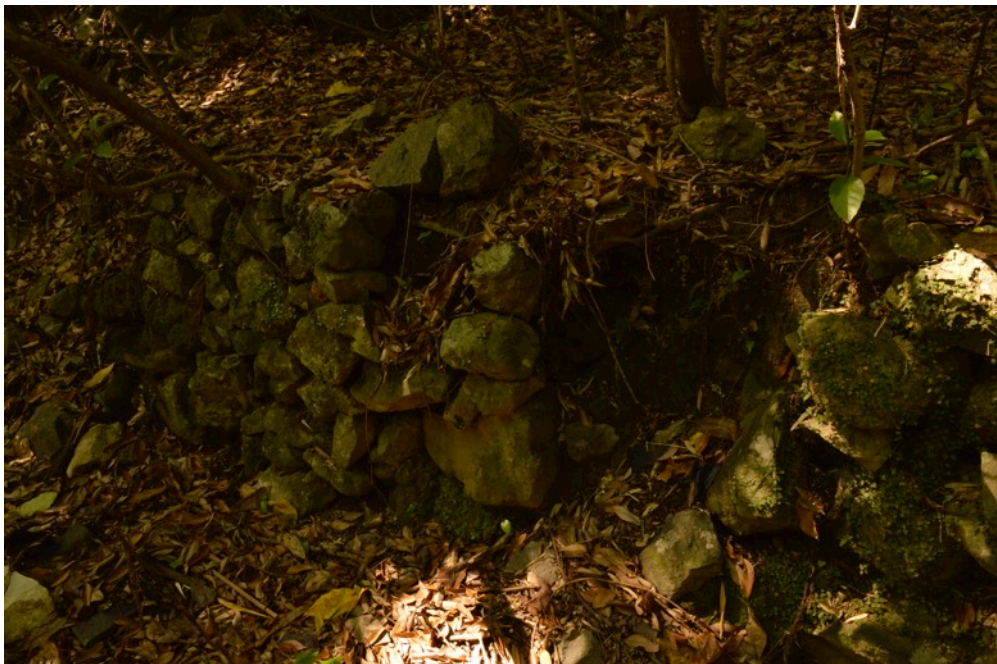
図 1-4 現況の石積みの写真 2
