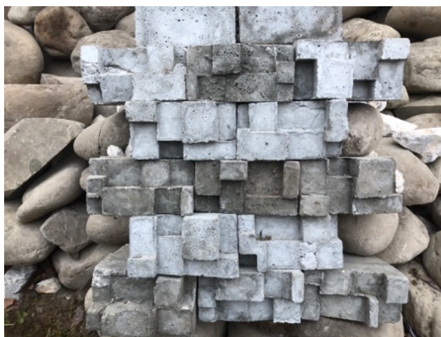
図 4-18 第2回仮施工時の完成写真
