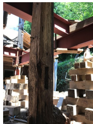
図 19. 枕木組 (2018/6/7) 図 20. 添え柱 (2018/6/7) 図 19～図 20 撮影者 (沖野)
