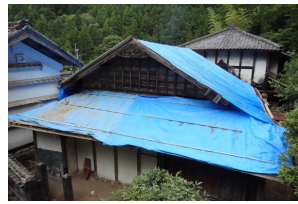
図 10. 解体工事 (2018/6/2) 図 11. 解体工事 (2018/6/5) 北側下屋野地板撤去 ブルーシート養生 図 4～図 11 撮影者 (吉田)
