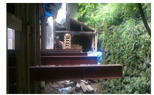
図 16. 鉄骨挿入 (2018/6/7) 図 17. 鉄骨挿入 (2018/6/7) 図 16～図 17 撮影者 (岡本) 注 3)
