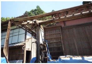
図 10. 解体工事 (2018/6/2) 図 11. 解体工事 (2018/6/5) 北側下屋野地板撤去 ブルーシート養生 図 4～図 11 撮影者 (吉田)
