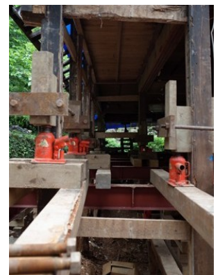
図 19. 枕木組 (2018/6/7) 図 20. 添え柱 (2018/6/7) 図 19～図 20 撮影者 (沖野)
