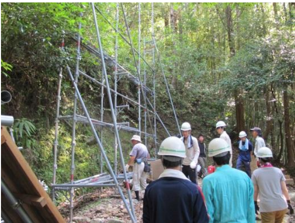
図4. 足場解体の様子
