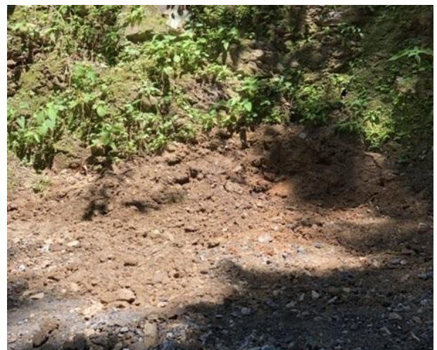
図7. 保護ブロック撤去後
