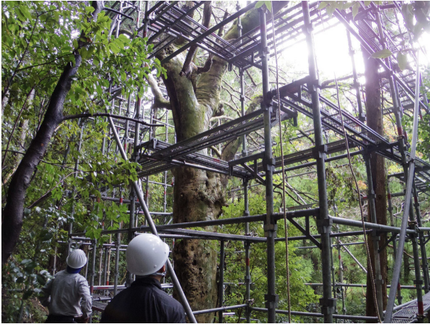
図1. 御神木の周囲に足場を組んだ状況
