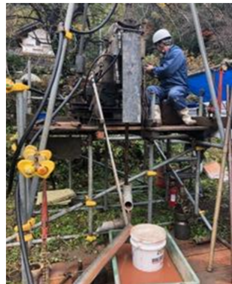
図 8. ボーリング掘削（2018 年 12 月 4 日撮影）
