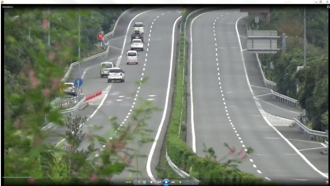
図 13 八代橋③(伊野付加車線車両挙動)
