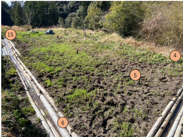
図 17. 施工後の経過観察 1 (2023/3/15)
