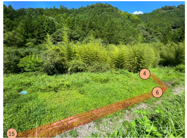
図 19. 施工後の経過観察 1 (2023/07/02)
