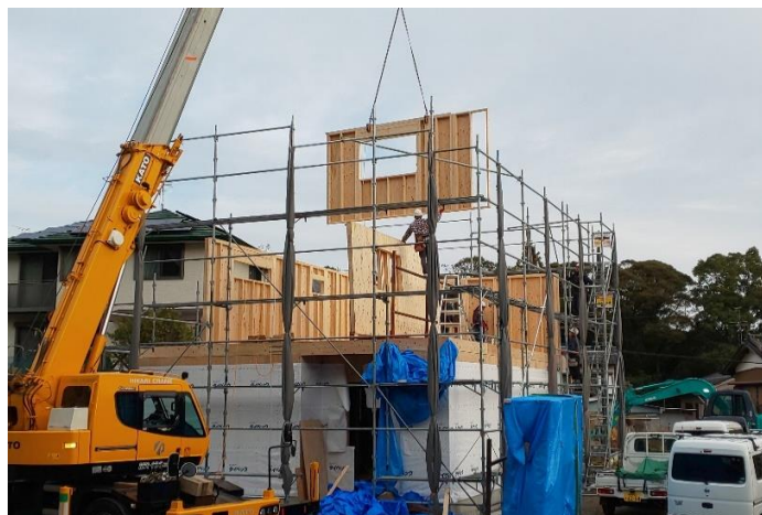
「2×4」工法で建設中の木造住宅
