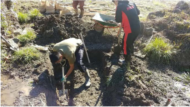
図 12. 本施工の様子
