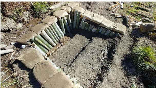
図 14. 壁面の竹補強
