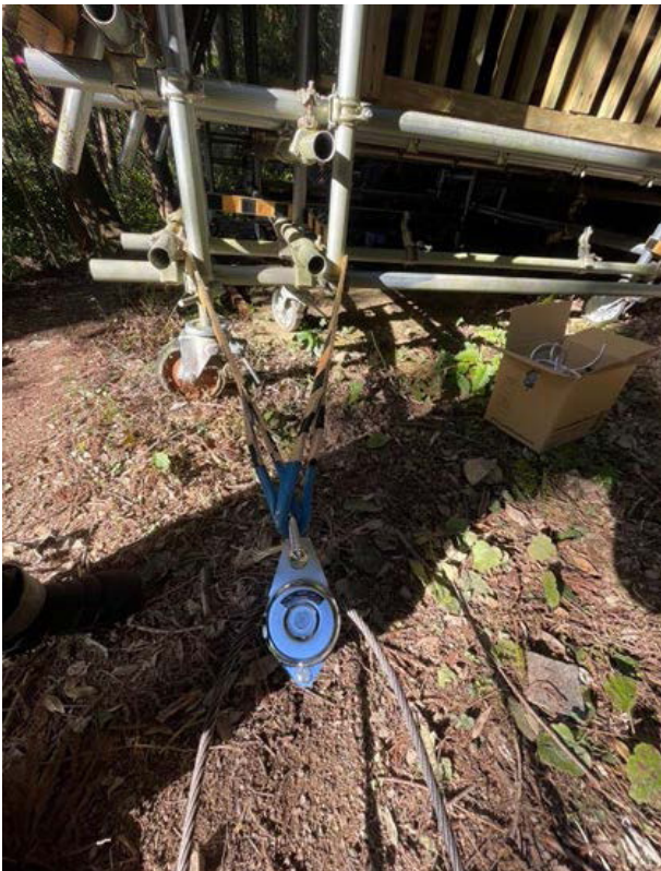
図 24. ベルトスリングと動滑車（本殿側）
