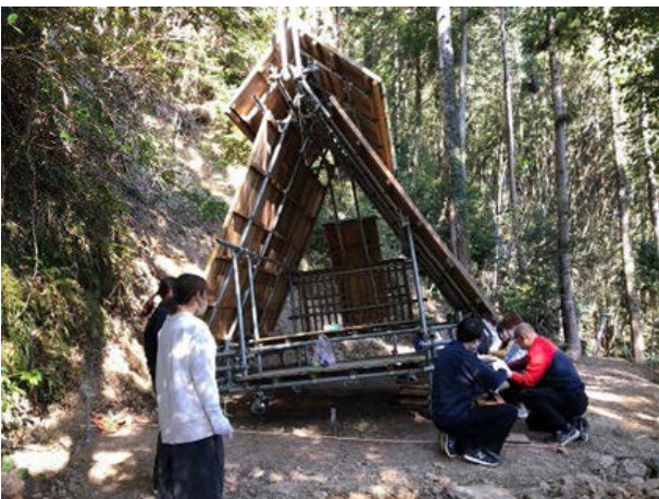
図 34. 足場ジャッキ交換の様子
