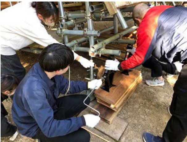
図 33. 足場ジャッキ交換の様子
