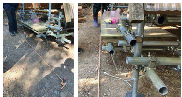
図 31. 杭とロープを設置した
