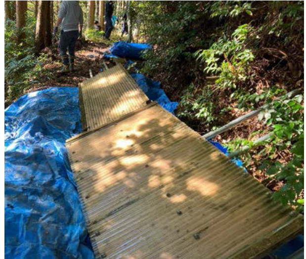
図 21. 庇移動完了の様子
