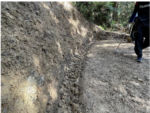
図 14. 水路の石詰め
