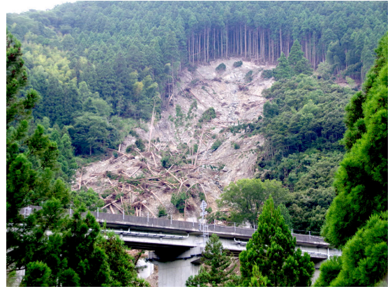
図 4. 大豊町で発生した斜面崩壊被害
