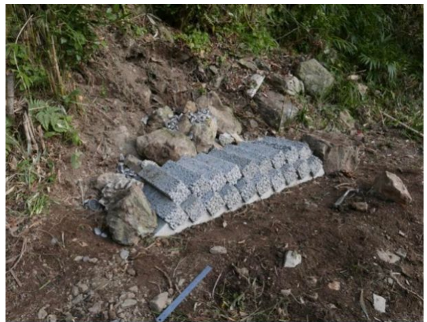
図 22. ブロック積み上げの様子
