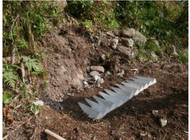
図 21. スペースブロック設置後の様子
