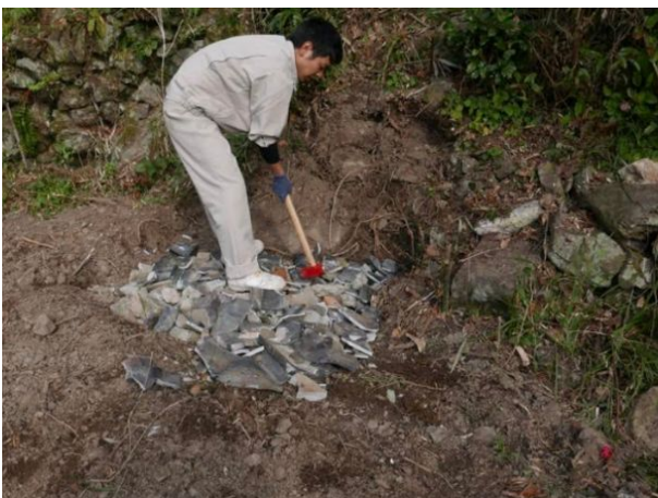
図 20. 粗骨材の敷き詰めの様子
