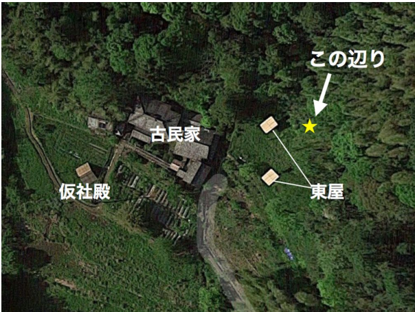
図 1. 対象となる石積み擁壁の位置
