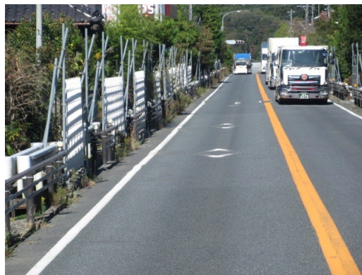
図1. 1Fに向かう国道6号線沿いの帰還困難区域(大熊町)
