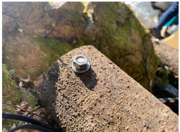
図 14. ハンガーボルト取り付け後
