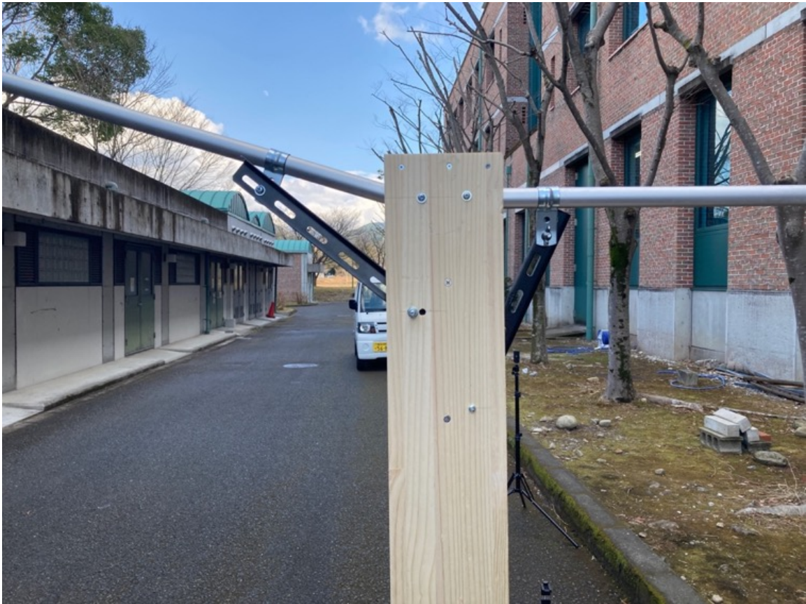
図 9-3 立バンドとプレートで支えた桁
