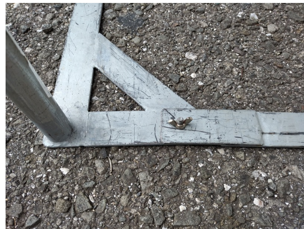
図 1-3 基礎とプレートの結合部
