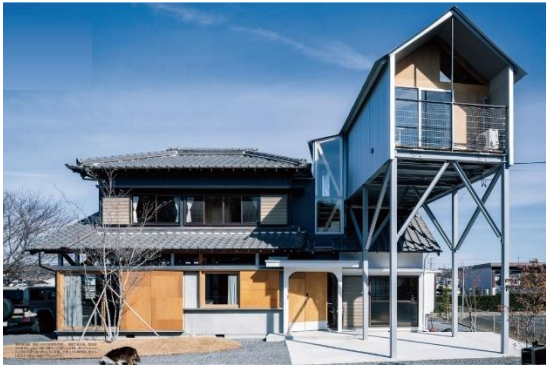
図 1-7.西坂部の家 外観写真
