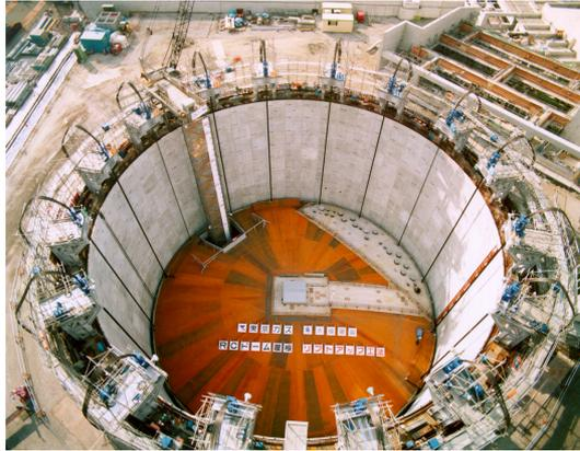
写真 5.2 コンクリート製屋根のリフトアップ
