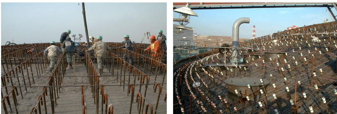
写真 5.5 仮設鋼製屋根傾斜部におけるコンクリート打設
