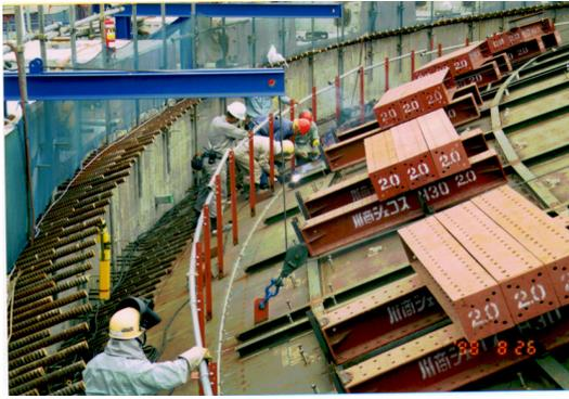
③ 側壁頂部と固定中の仮設鋼製屋根
