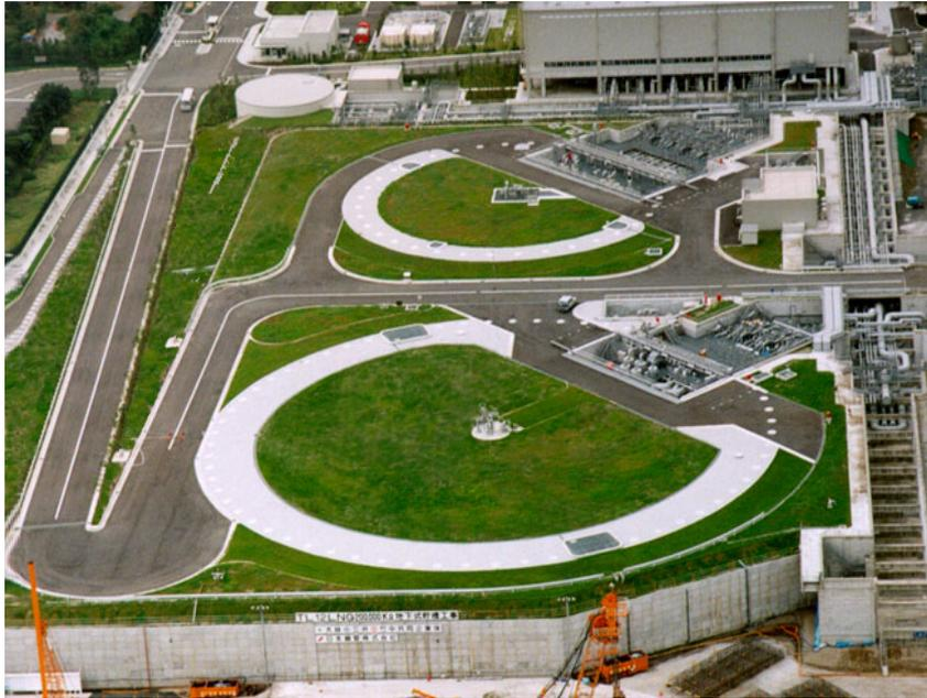
写真Ⅰ 屋根上部に植栽を施した埋設式地下式貯槽の外観
