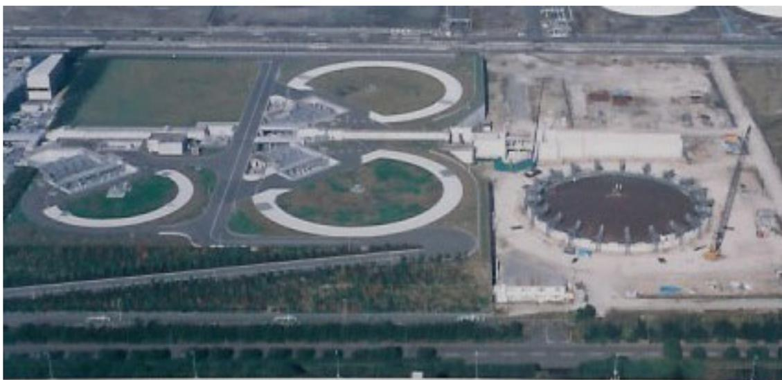
写真Ⅲ 屋根上部に植栽を施した埋設式地下式貯槽の外観【東京ガス(株) 扇島 LNG 基地】
