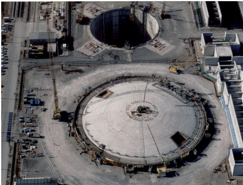
写真Ⅱ 覆土前における20万 KL LNG 埋設式地下式貯槽のコンクリート製ドーム屋根
