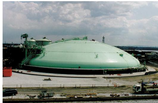
(一般的な地下式貯槽の本設鋼製屋根)
