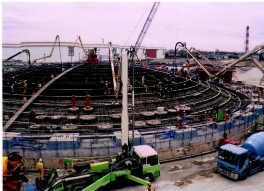
④ コンクリート打設時の仮設鋼製屋根
