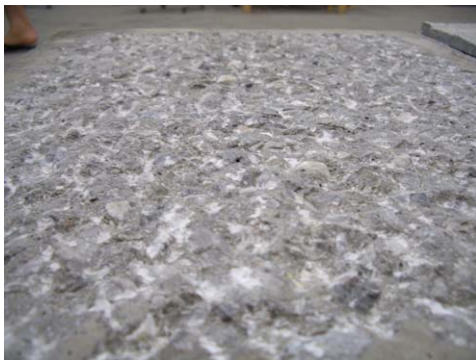
写真-6 「はつり仕上げ」の表面性状
