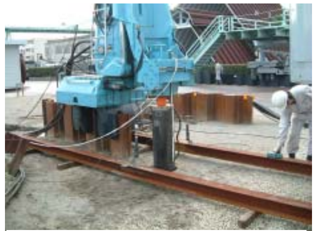
杭の鉛直載荷試験
