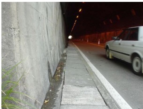
図 2 未対策の井の岬トンネル
