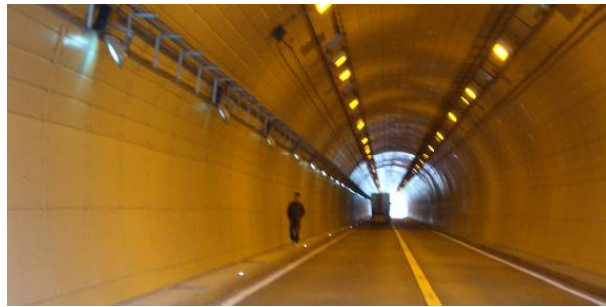
図 10 対策後の井の岬トンネル
