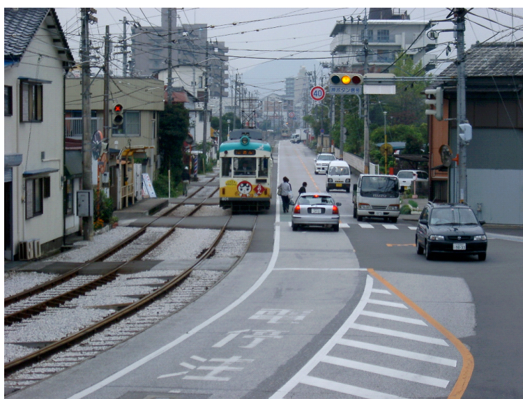
図 19 国道 195 号のノーガード電停
