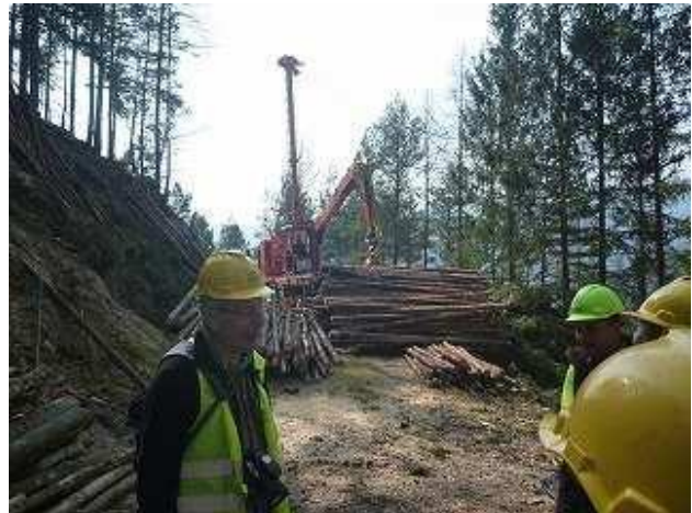
②集材作業中のタワーヤード
