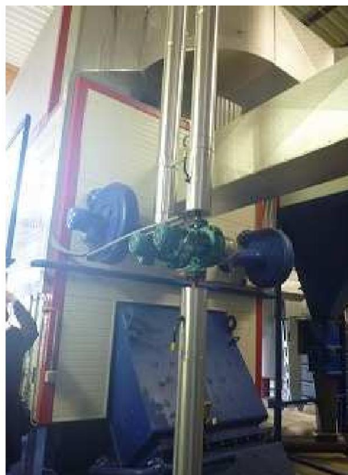
⑤チップを押し出して燃やすボイラー 中央下の青い部分をゆっくりと材料が送られていき、 その間にバイオマスを乾燥させる
