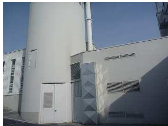
③地域暖房施設外観
