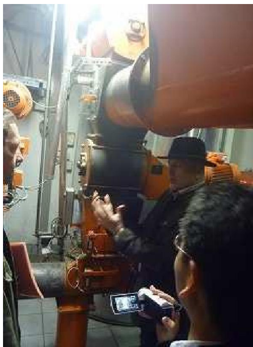
⑥水分の多いバイオマス用のボイラー 水分は40%まで(パークは使えない)
