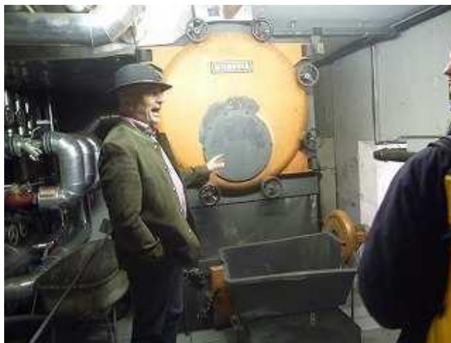
④おが粉を圧力で噴射させるボイラー
