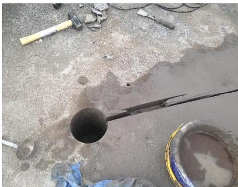
図 21 磁気センサ埋設穴
