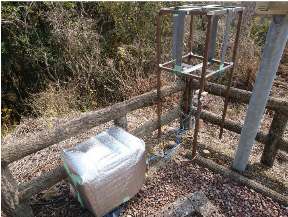
Fig.3.2 直交ループアンテナの設置状況（芸西天文学習館南東側）
