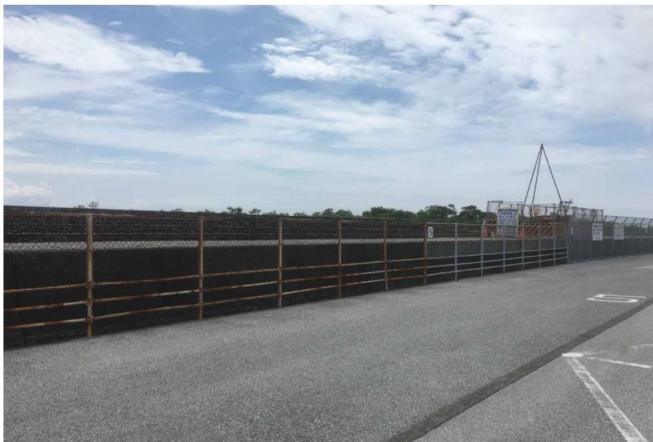
図 4-3 東浜と駐車場を隔てるフェンス
