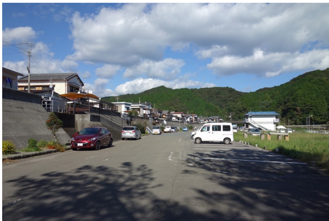
図 2-7 現況の防潮堤（海側）
