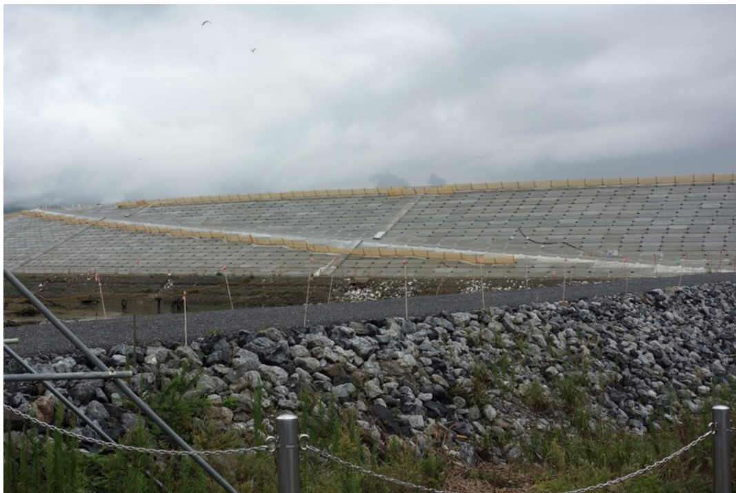
図 1-2 陸前高田市で建設が進められている防潮堤
