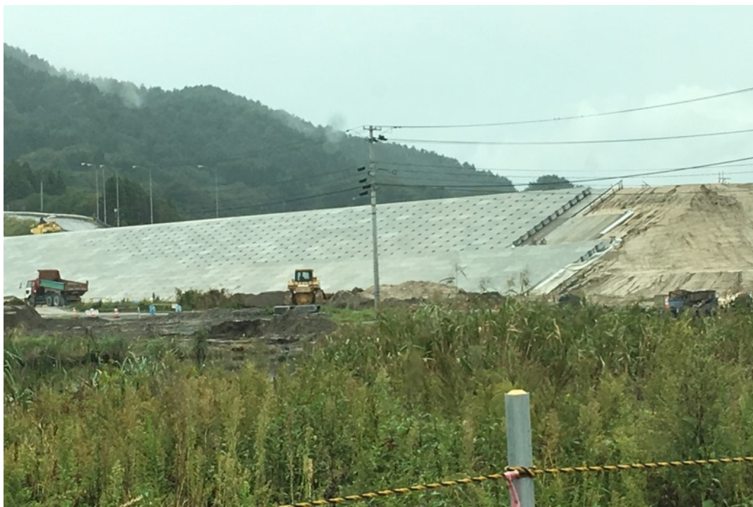
図 3-5 単調な仕上げの防潮堤（東北）
