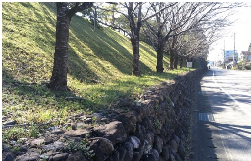
図 3-24 高知工科大学教職員駐車場付近の法面
