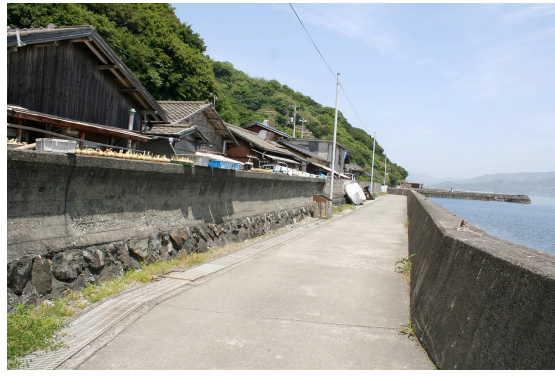
写真 6-10. 海風を遮るコンクリート壁
